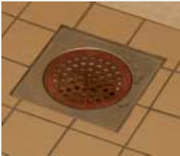
Kuparisen lattiakaivon mikrobisto oli ympäristön ja ihon normaaliflooraa, kun taas referenssinä olleessa lattiakaivossa elivät myös virtsa- ja ulosteperäiset gram-negatiiviset bakteerit.
