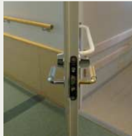
Potilashuoneen ovenkahva oli huoneen sisäpuolella messinkiä ja ulkopuolella kromattua metallia. Messinkisessä ovenkahvassa ei havaittu bakteereja tutkimuksen aikana.
