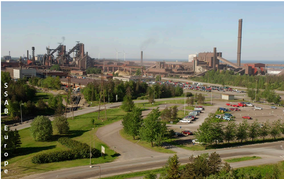
Näkymä SSAB:n Raahen terästehtaalta. Vasemmalla kaksi masuunia, oikealla sintraamo, joka poistettiin käytöstä vuonna 2011.
